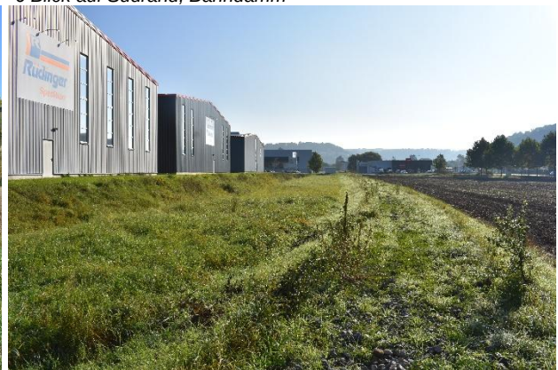
8 Bahndammverlauf Richtung Dörzbach
